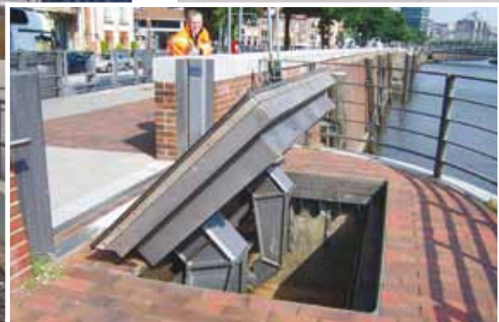
Kreuzungsbauwerk mit Klappstore: die zur Hafen-City führende Kibbelstegbrücke.
