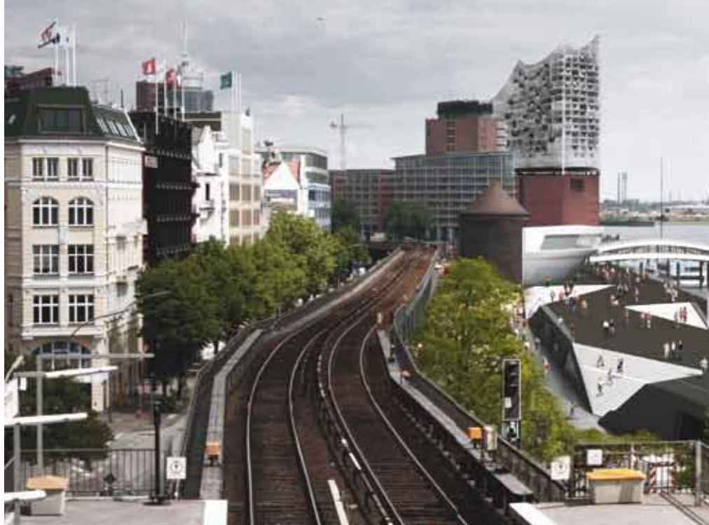
Das Foto oben zeigt die Hochwasserschutzanlage Niederhafen im gegenwärtigen Zustand. Auf der Abbildung darunter ist der Entwurf des Neubaus mit erhöhter Flanier-
