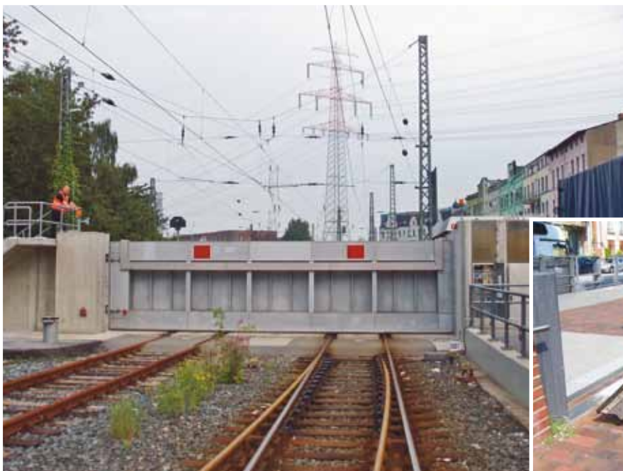
Das Flutschutztor am Bahnhof Alte Süderelbe kreuzt die Gleise der Hafenbahn auf der Strecke nach Hamburg-Finkenwerder.
